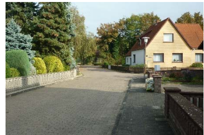
Mauer mit Metallelement
