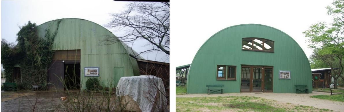
Reithalle in Altenwahlen vor (links) und nach der Sanierung (rechts) © Karin Bukies, Stadtlandschaft
