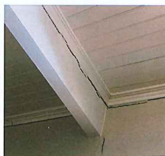
Absackende Fußböden und Wände
