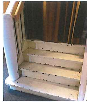
Treppe ins Dachgeschoss mit Vorhang als Türersatz
