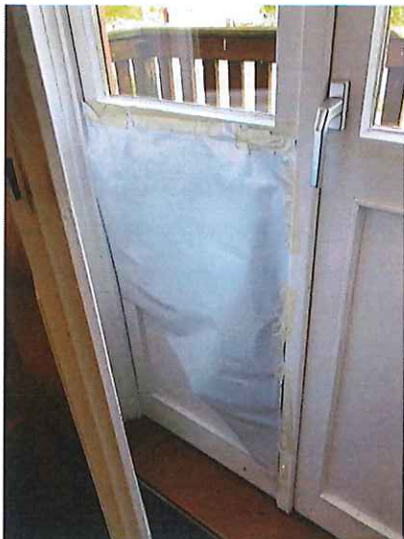
„Isolierung“ der Fenster-Elemente
