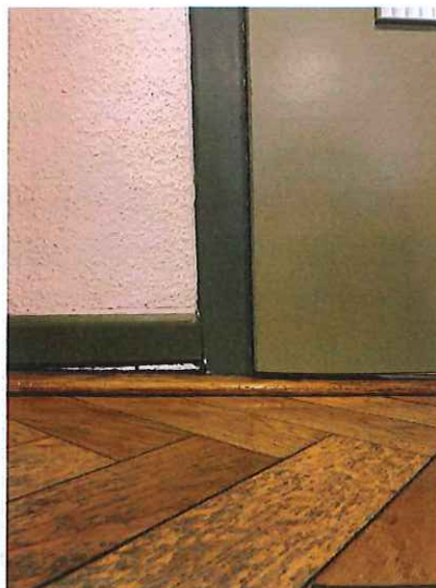
Absackende Fußböden und Wände
